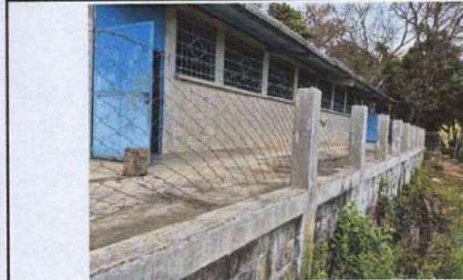
FOTO 2: Resane y refuerzo a barandal frente a corredor.
