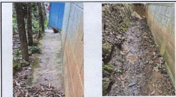
FOTO 9: Reparación de cuneta en mal estado, ya que las paredes de la escuela se mantienen con humedad porque el agua no sale y se empoza.
