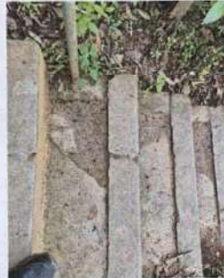
FOTO 3: Reparación de gradas en mal estado, en su mayoría presenta hundimientos y están muy altas, los niños se tropiezan, por lo que representa un peligro.
